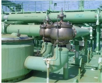
タンク安全弁(エルボ仕様) Safety valve(with Elbow)
