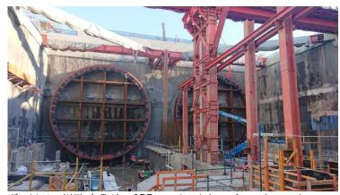
ヴィクトリア州政府発注、CPB コントラクターズ ・ジョン ホーラン ド共同企業体(CPBJH-JV)施工の本工事「ウエスト ゲートトンネ ル プロジェクト」は、マリビルノン河に架かるウエストゲート橋に代わ る重要な代替え交通手段となり、渋滞の緩和や住宅街を通る何 千台ものトラックのルートを変更する、都市形成プロジェクトとなっ ております。シールドマシン1号機(ベラ)は2022年3月に発進、 18 ヶ月かけ全長 4km の市外行きトンネルを掘削、ウエストゲート 高速道路の北アルトナと合流予定です。2 号機(ビダ)は同年 4 月に発進し全長 2.8km の市内行きトンネルを 12ヶ月かけて掘削 し、ウエストゲート高速道路の西にあるウイリアム道路と合流予定 です。シールドマシン発進坑口には当社エントランスシール装置 「RIPP type-A」が採用されており、両坑口ともにシールドマシン発進 時のシール性能は良好でした。
