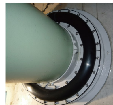
壁貫通配管部シールカバー Seal cover for pipe penetrating wall
